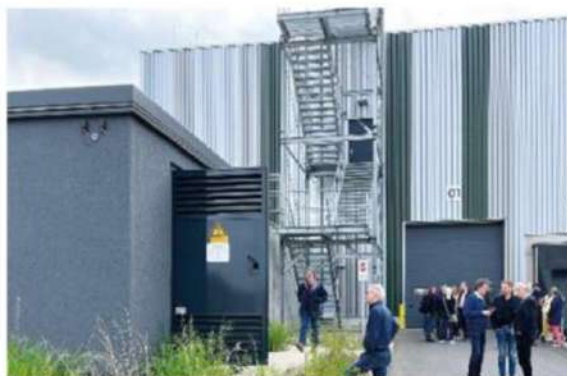
Unscheinbar: Nur die Trafostation weist auf die Anlage hin, die Module auf dem Dach der Logistikhalle sind von unten nicht zu sehen.
