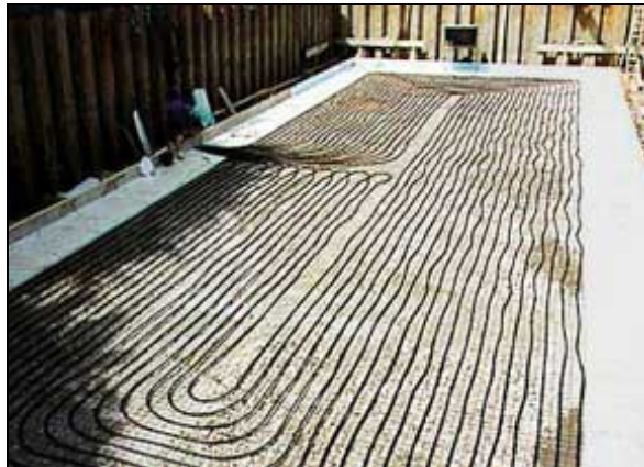
Abb. 40: Beispiel einer thermisch aktivierten Betonplatte ([53]).
