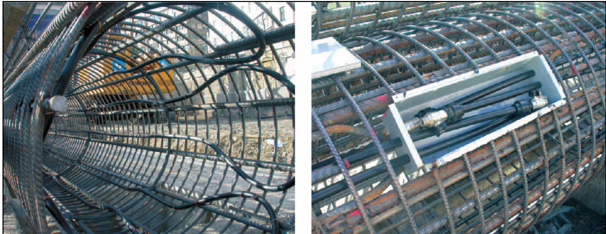
Abb. 39: Geothermische Erschließung mittels Energiepfählen ([52]).
